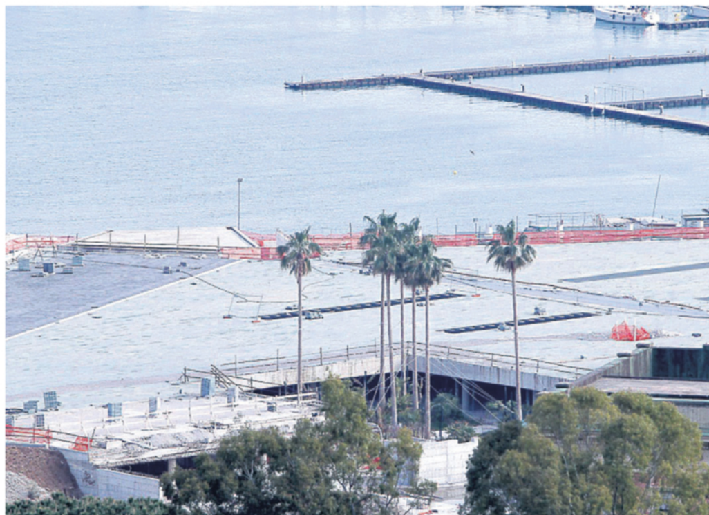
Cantiere Piazza della libertà; a sinistra, il professor Nicola Augenti
