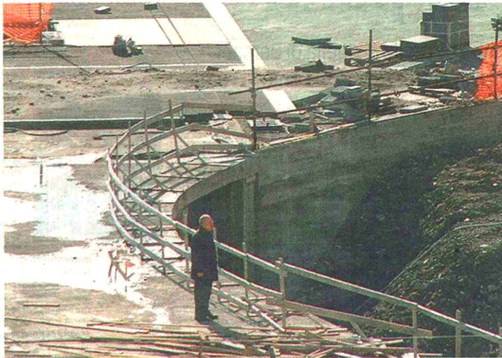
Il cantiere di Piazza della Libertà e, a destra, il professore Nicola Augenti
