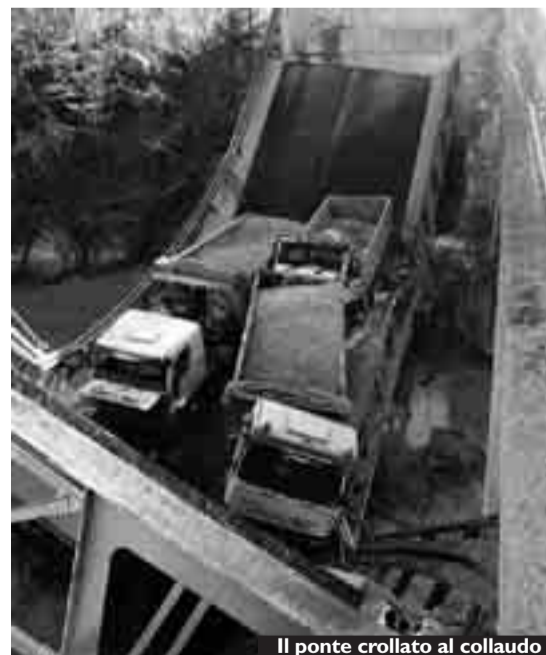
Il ponte crollato al collaudo
